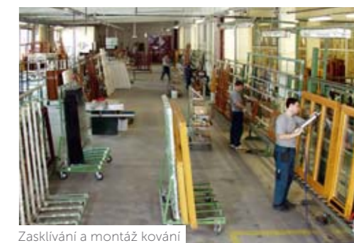
Zasklívání a montáž kování
